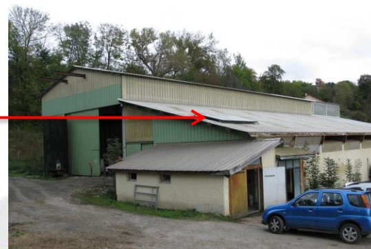
Panneaux solaires pour l'ECS
