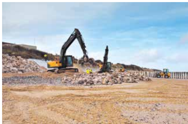
Les travaux pour protéger la côte et les habitations entraînent des frais supplémentaires pour les communes.
