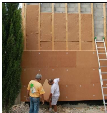
Isolation par l'extérieur en fibre de bois
