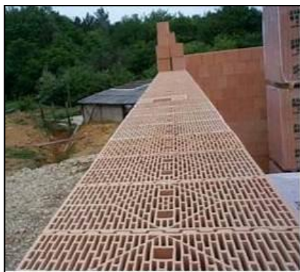
Construction en monomur de terre cuite
