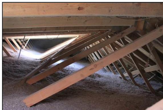
Isolation de combles perdus en ouate de cellulose
